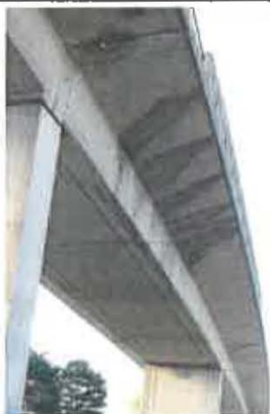
Da016 Dalle inférieure, axes 0-16 301 Zones humides côté droit entre Pi15 et Pi16 + côté gauche entre Pi10 et Pi11 Ecoulement depuis la bordure droite
