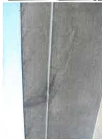
Da016 Dalle inférieure, axes 0-16 301 Zones humides côté droit entre Pi15 et Pi16 + côté gauche entre Pi10 et Pi11 Ecoulement depuis la bordure droite
